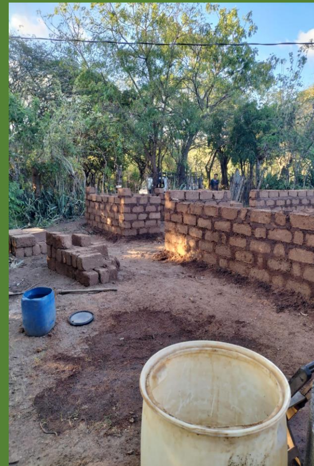
Fases de construcción
